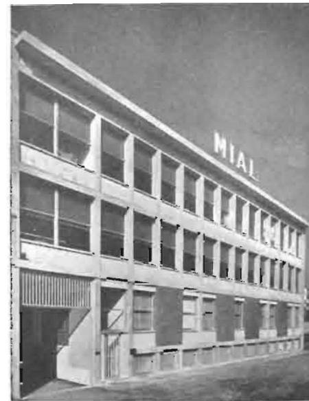
FRNOTE DELLA NUOVA COSTRUZIONE
